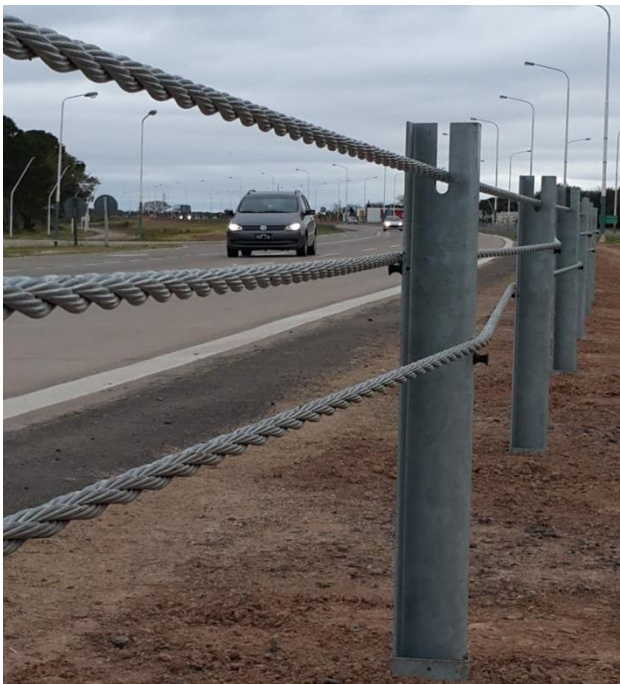
Instalación de barrera flexible Ruta Nacional N°16 – Provincia del Chaco
