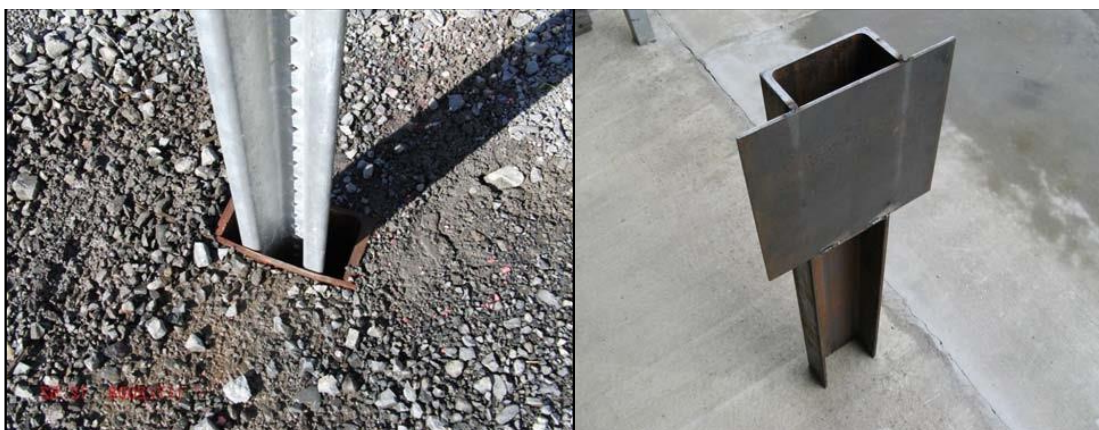
POSTE ENTERRADO CON VAINAS DE ACERO
