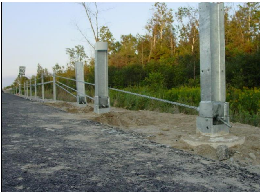
Sistema de Anclaje NUCOR
