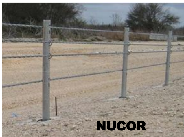
Con Bases individuales de Hormigón
