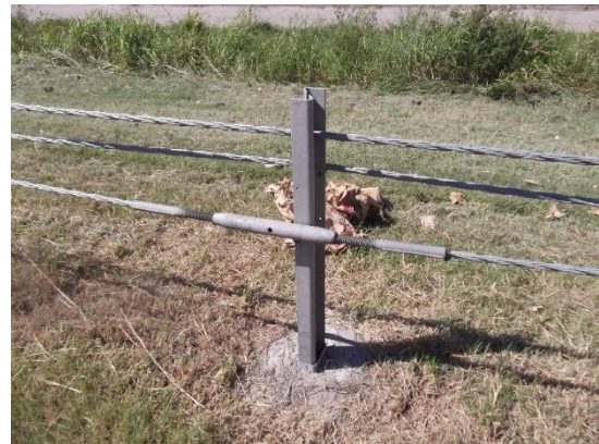
Uniones en coincidencia con postes
