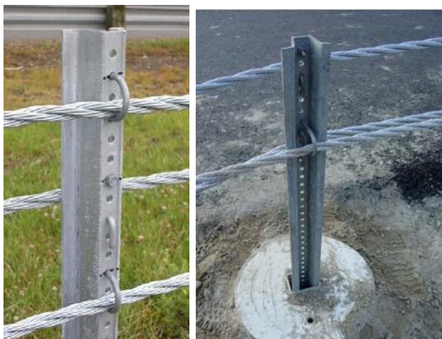
Configuración de cables en Medianas
