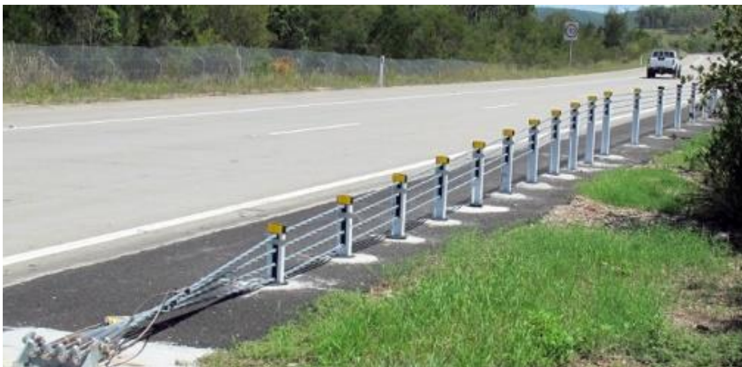
Sistema de Anclaje SAFENCE
