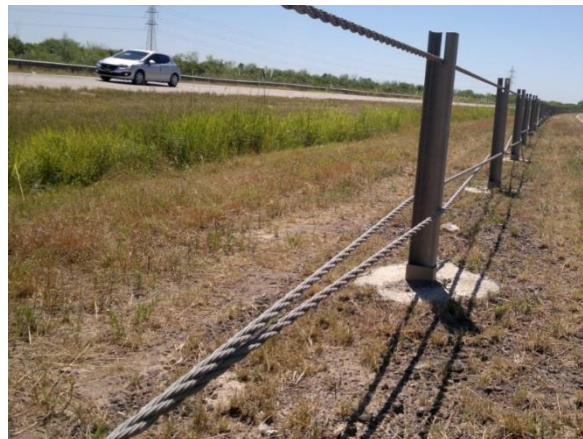
Inadecuada altura de los cables
