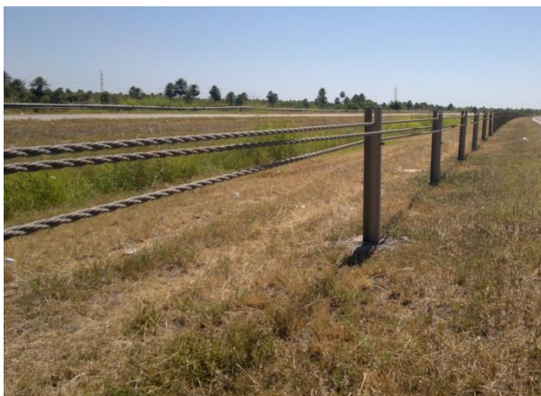
Inadecuada altura de los cables
