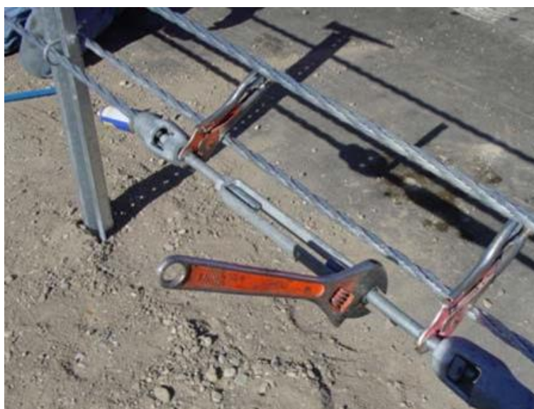
Ajuste de cables mediante Uniones NUCOR
