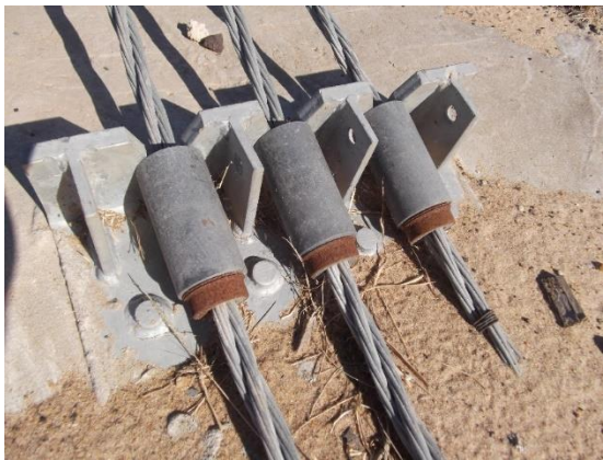
Piezas de anclaje oxidadas
