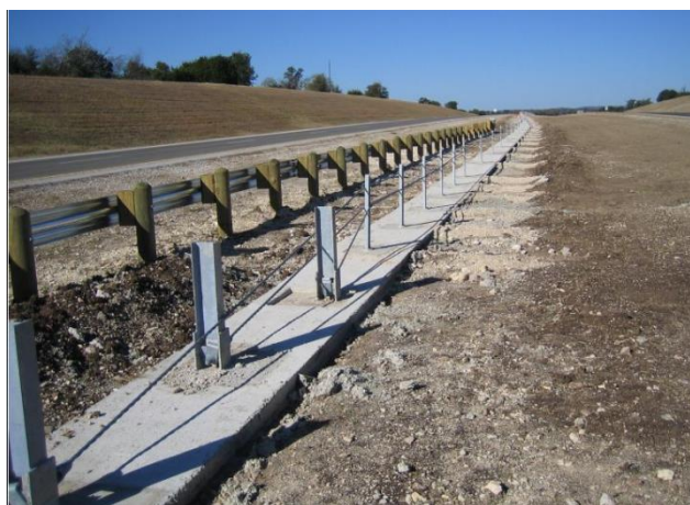
Sistema de Barreras NUCOR con Zapata continua
