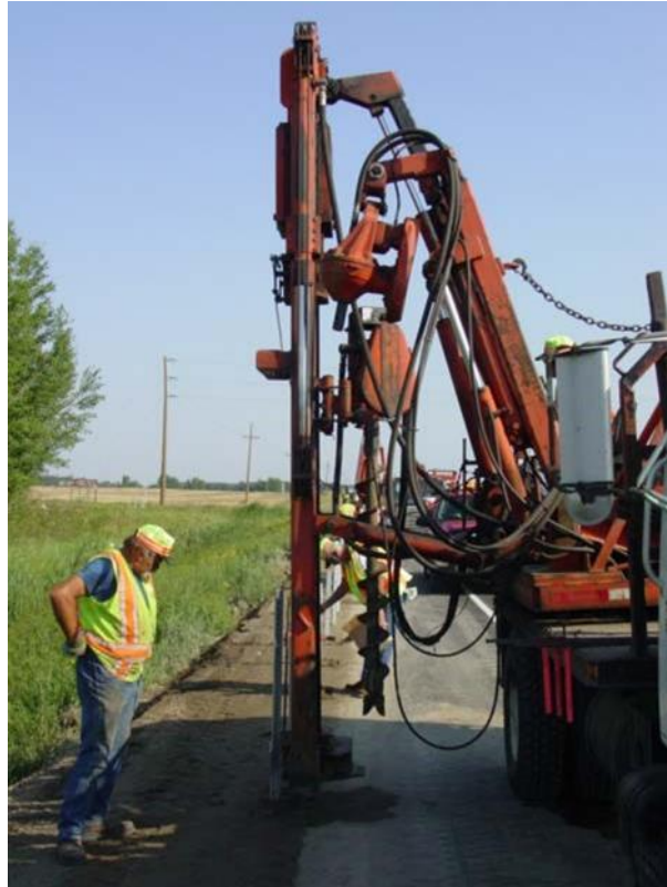
POSTE ENTERRADO DIRECTAMENTE EN EL SUELO
