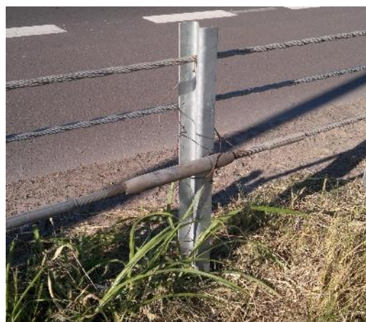
Posición inadecuada de las piezas de unión
