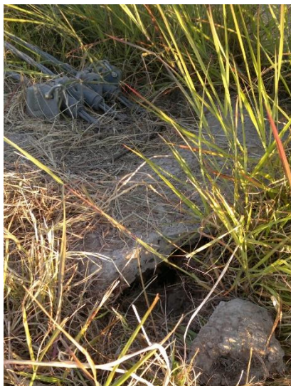
Base de anclaje socavada
