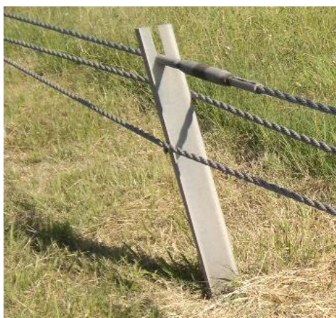
Posición inadecuada de las piezas de unión
